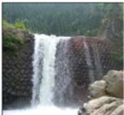
砂防・治山ダム
