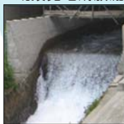
既設発電所放流
