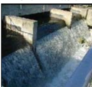
下水処理排水
