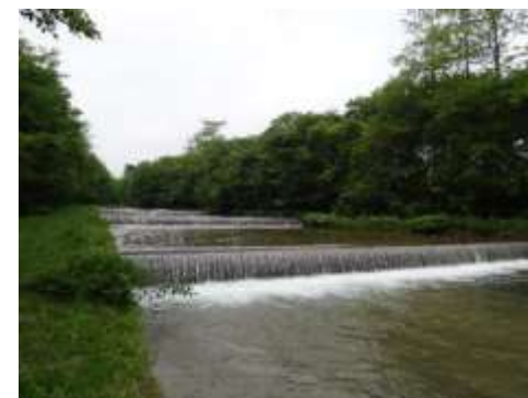
温水路（落差工）
